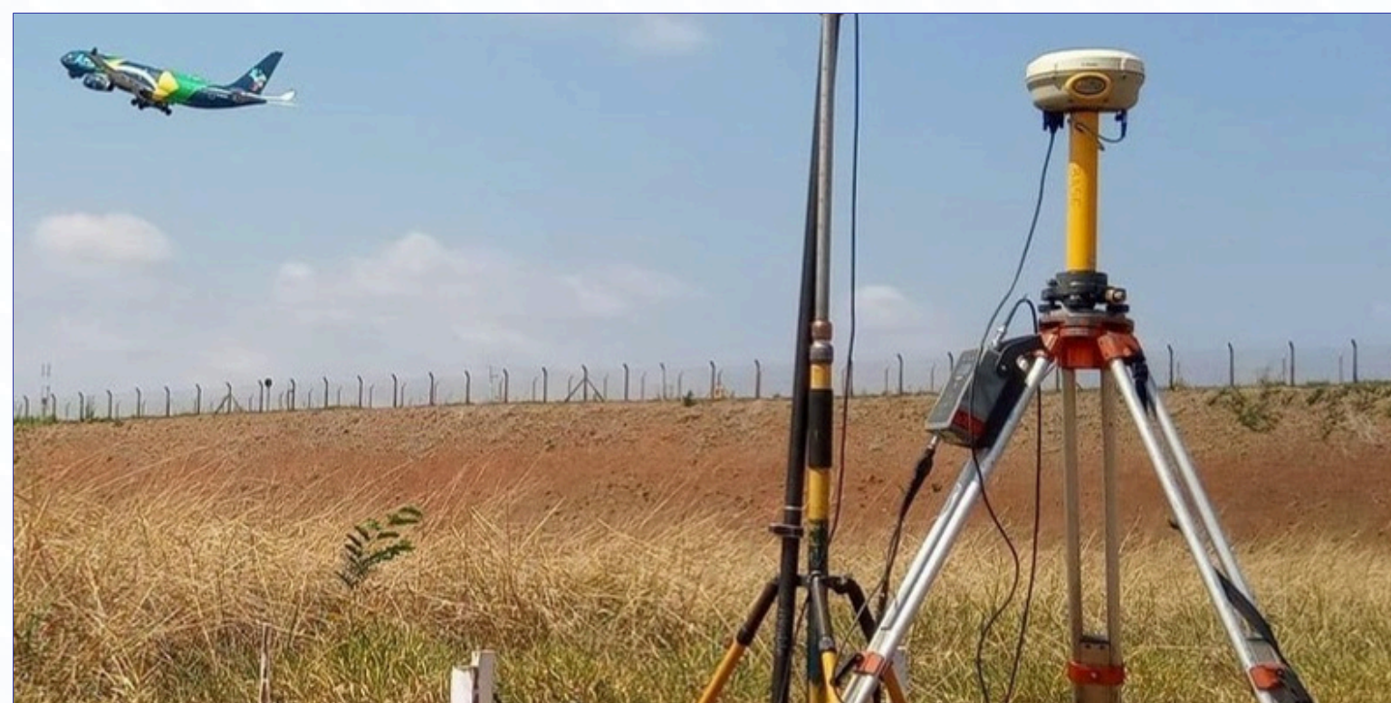
Levantamento planialtimétrico nas áreas de entorno do aeroporto - Campinas/SP
