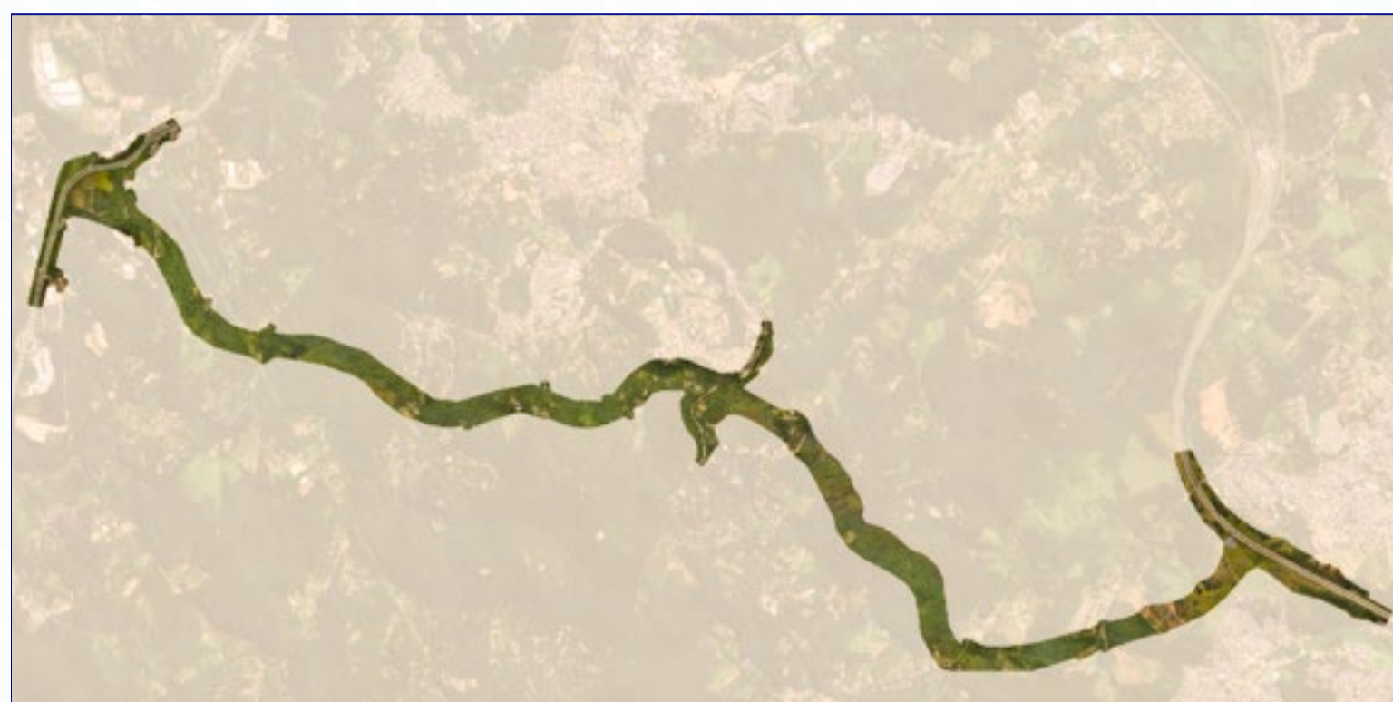
Aerolevantamento para projeto funcional de implantação de nova rodovia - São Paulo
