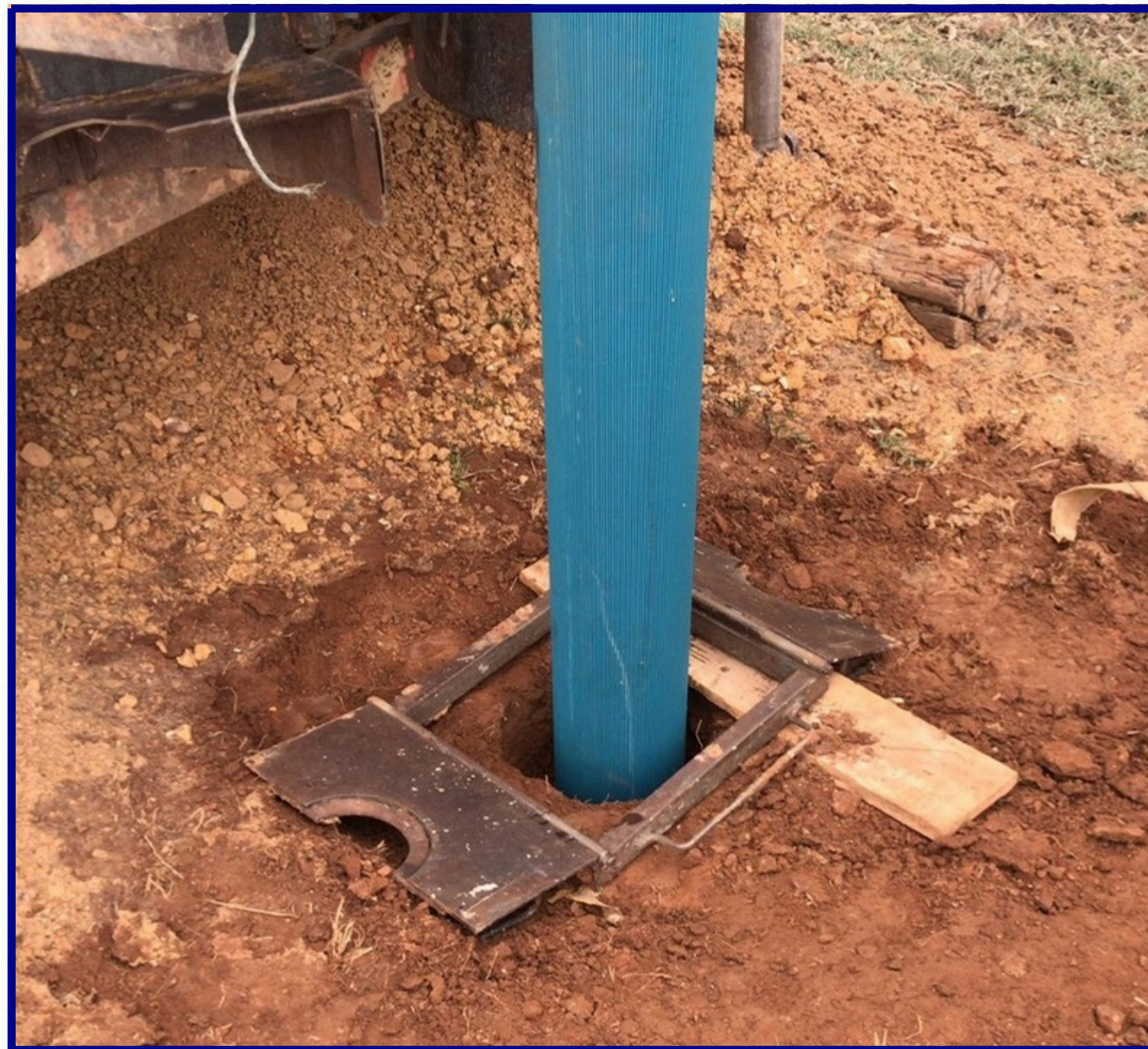
Perfuração de poços com tubo geomecânico de 4"
